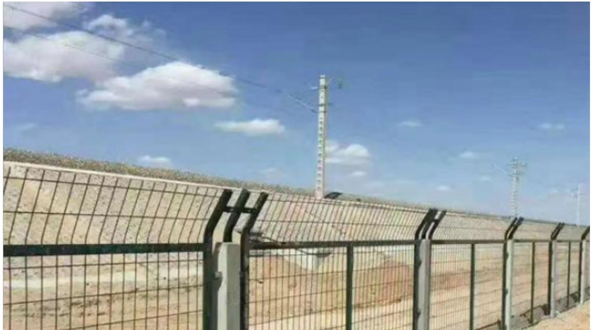
电焊网是用质量低碳钢铁丝排焊而成，然后再冷镀（电镀）、热镀□PVC包塑等表面钝化、塑化处理。达到网面平整、网目均匀、焊点牢固、局部机加工性能良好、稳定、耐候性好、防腐蚀性好。中文名电焊网外文名weldedwiremesh用途建筑，工业设备防护，农业技术自动化焊接设备焊接成型表面处理镀锌，浸塑，喷塑材质低碳钢丝，不锈钢丝目录1基本特点2主要用途•外墙保温工程应用•钢结构应用•新式水貂笼3产品种类4涂塑5具体应用•防护栏•产品优点电焊网基本特点编辑电焊网英文:weldedwirenet□weldedwiremesh电焊网又称外墙保温铁丝网、镀锌铁丝网、镀锌电焊网、钢丝网、排焊网、碰焊网、建筑网、外墙保温网、装饰网、铁丝网，方眼网，筛网，防裂网。不锈钢电焊网，是采用质量不锈钢丝排焊而成，更具耐酸、耐碱、焊接牢固、美观、用途\*\*\*等特点。包装：电焊网一般包装为防潮纸（颜色多为灰白色、黄色，外加商标、合格证等），有的像，由于丝比较细软，再加上是小卷的，客户常要求打捆装袋处理，以防止装运造成的划损等。电焊网的网丝有直的，也有带波浪形弯的（也称荷兰网）。
